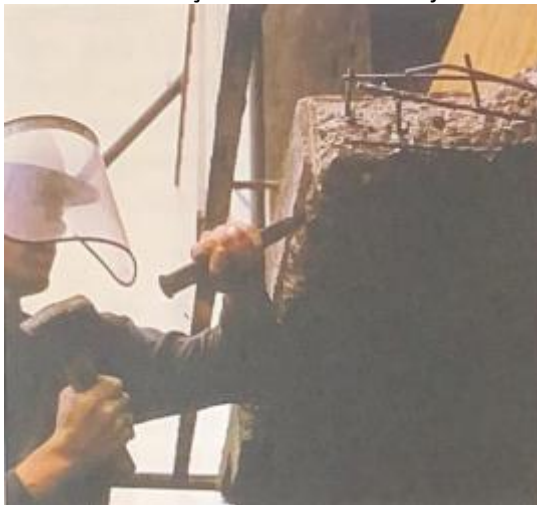
Figura 26 – Demolição do concreto já danificado.
