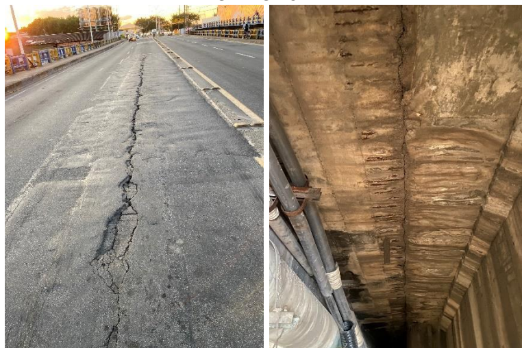
Figura 15 – Junta de dilatação entre a ponte nova e o alargamento. Vista superior e inferior.
