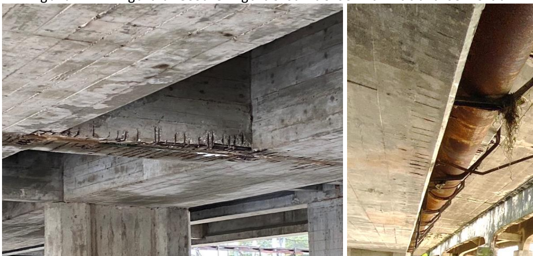
Figura 17 – Viga travessa e viga do caixão com armadura corroída.
