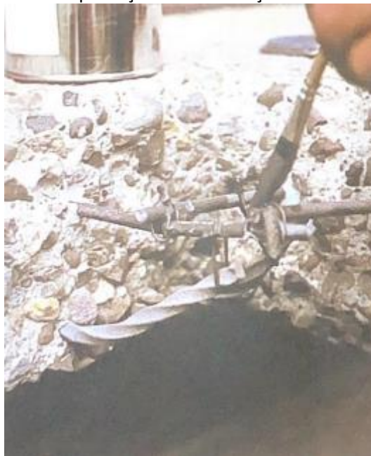
Figura 28 – Aplicação de Proteção de Armadura.
