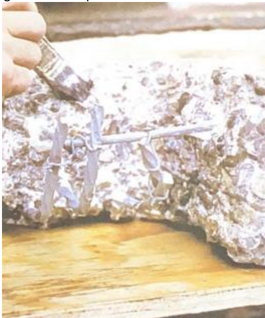
Figura 30 – Aplicar Ponte de Aderência.
