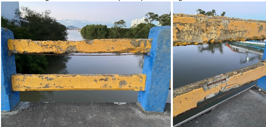
Figura 5 – Guarda-corpo da ponte antiga danificado.
