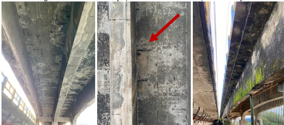
Figura 6 – Fundo da laje / Armadura corroída / Aba da laje.
