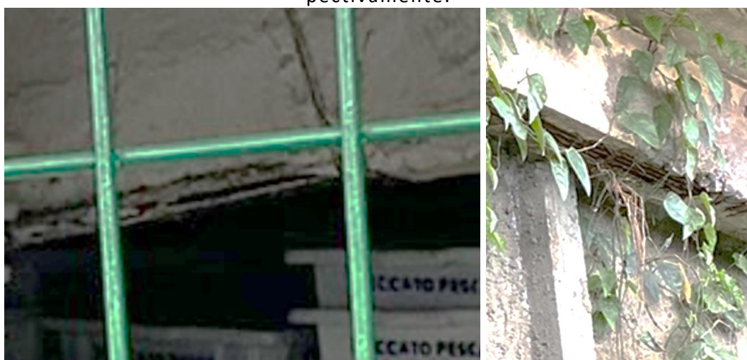
Figura 10 – Vigas com armadura exposta dentro do vazio sobre a rampa e fora, respectivamente.
