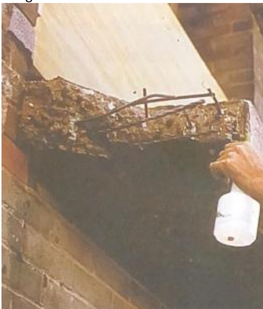
Figura 29 – Umedecer substrato.
