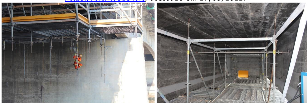
Figura 39 – Andaime suspenso, instalado em obra na ponte Osvaldo Cruz. Fonte: https://bit.ly/3LOYJlt , acessado em 27/09/2022.
