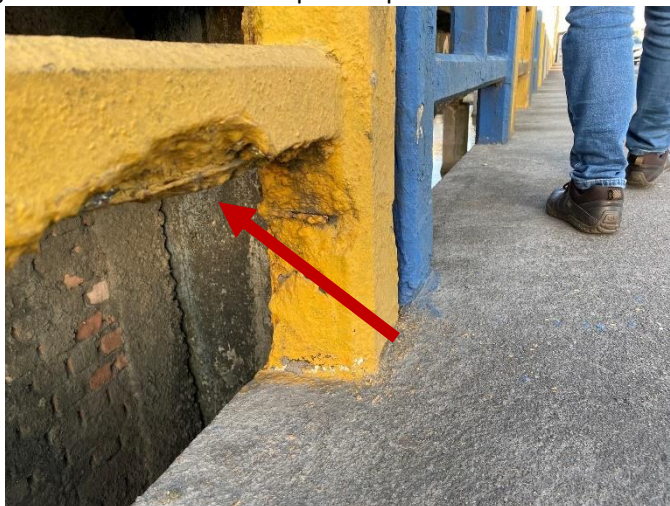
Figura 13 – Guarda-corpo da ponte nova danificado.
