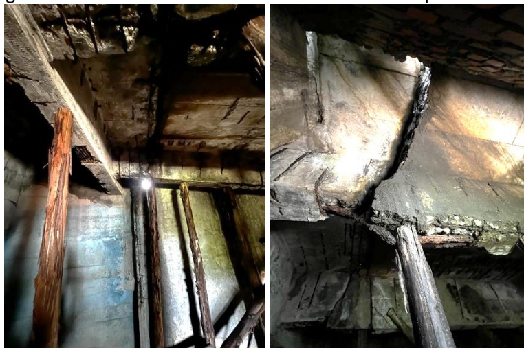
Figura 12 – Estrutura deteriorada sob a rampa e acesso.
