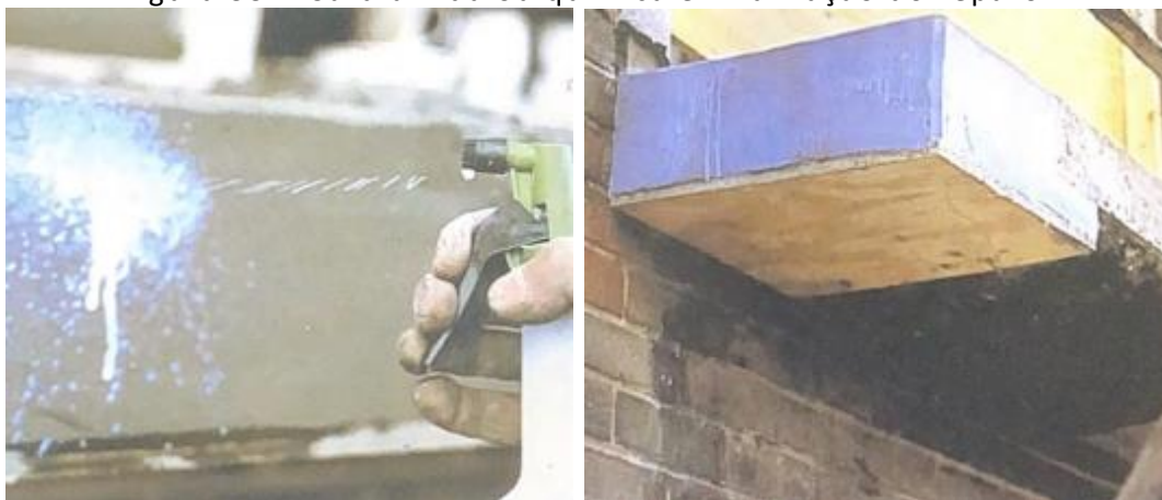
Figura 33 – Cura úmida ou química e finalização do reparo.
