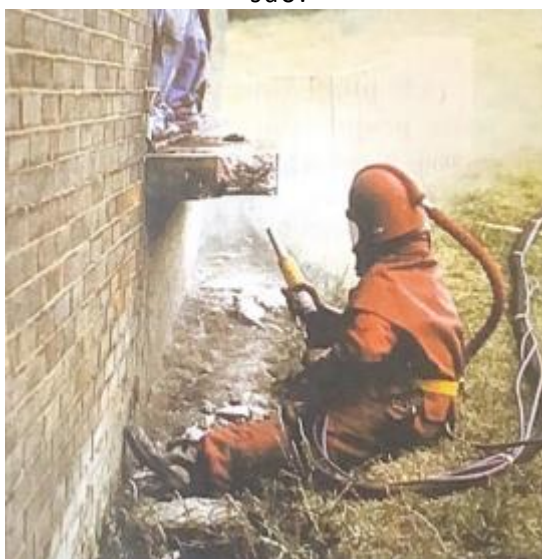
Figura 27 – Limpeza da armadura danificada com Hidro-jateamento com Ultrapressão.
