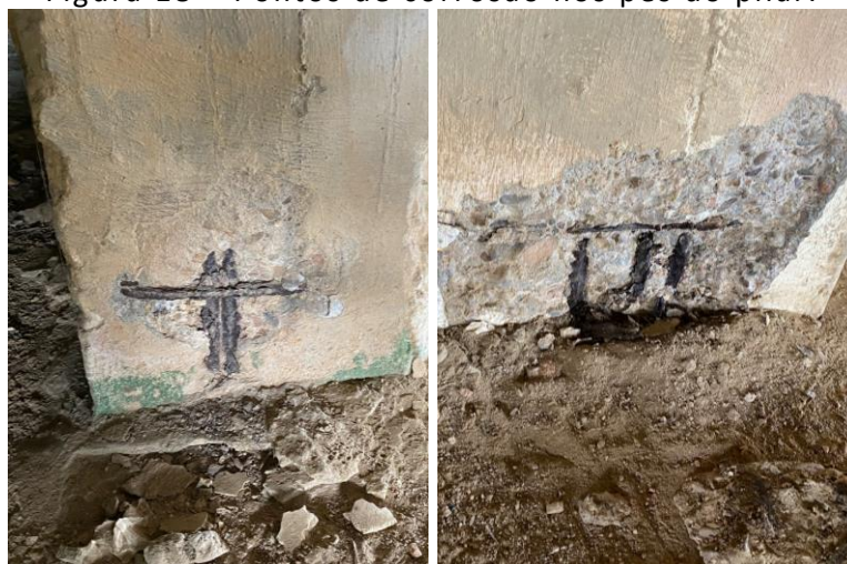
Figura 18 – Pontos de corrosão nos pés do pilar.
