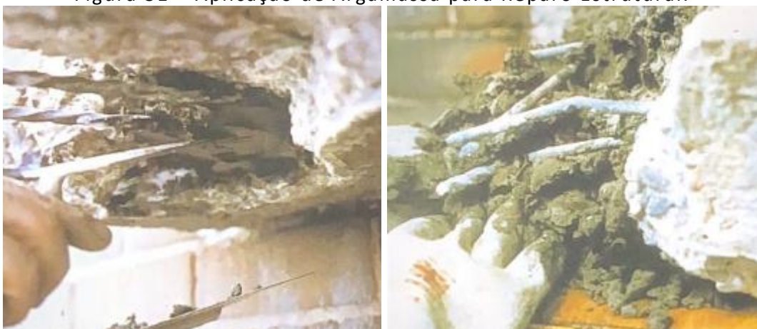
Figura 31 – Aplicação de Argamassa para Reparo Estrutural.
