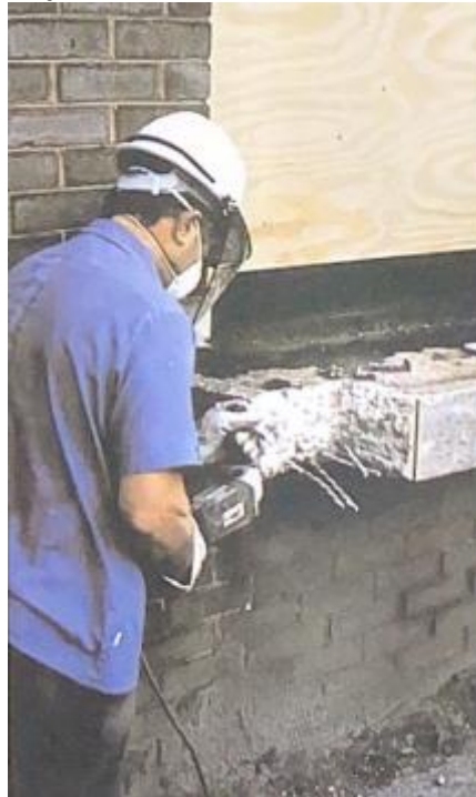
Figura 25 – Delimitação da área a ser tratada com Disco de Corte.
